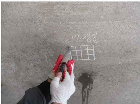
반발경도 측정 현황(측벽부)①
