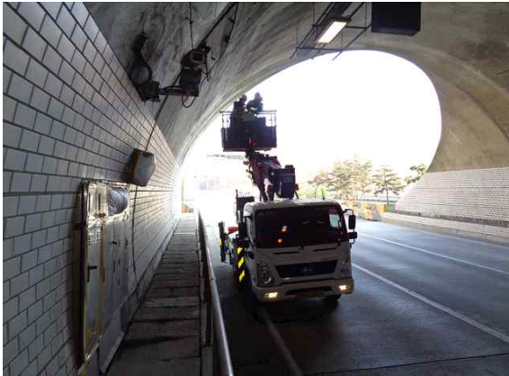
고소작업차를 이용한 외관조사 현황①
