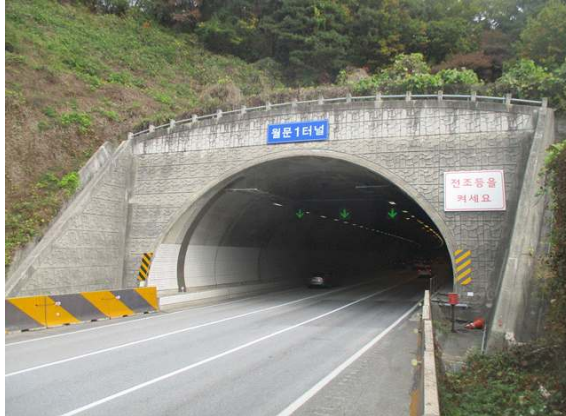
시점부 옹벽 전경
