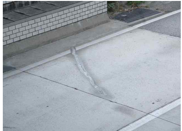
포장부 SPAN.142 균열 보수
