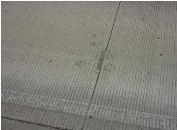
포장부 SPAN.122 박리 보수
