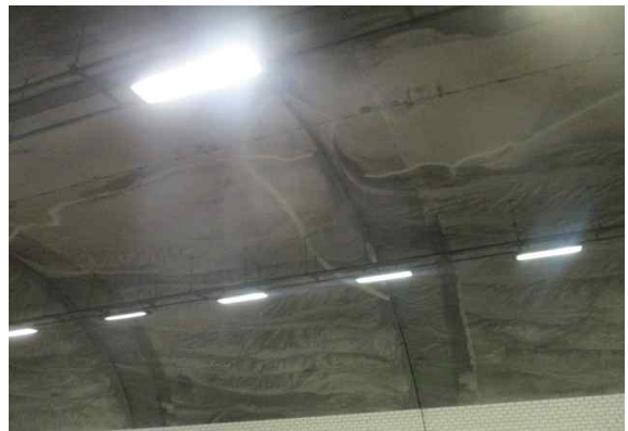
라이닝 SPAN.63 균열 보수
