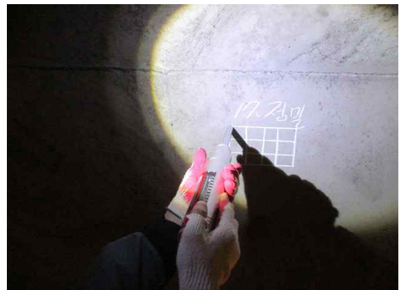
반발경도 측정 현황(측벽부)②
