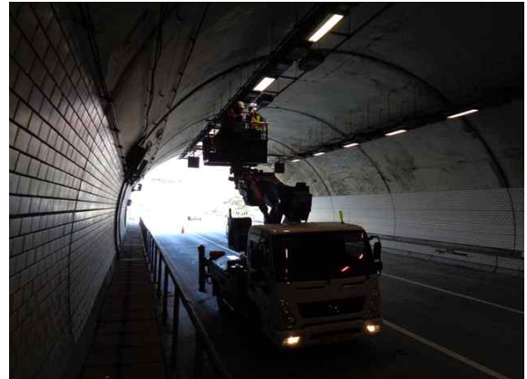
고소작업차를 이용한 외관조사 현황②
