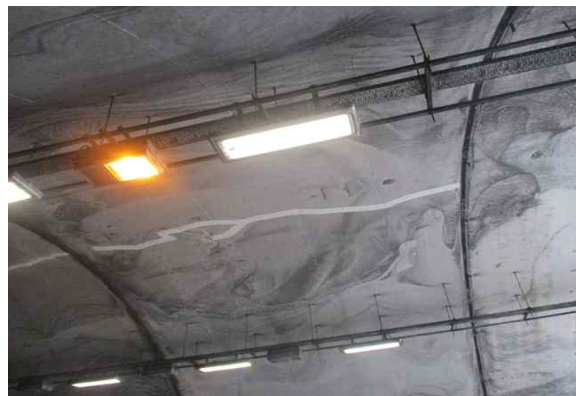
라이닝 SPAN.140 균열 보수
