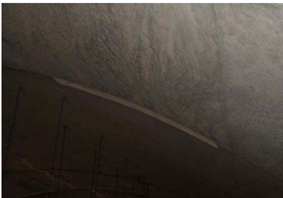
라이닝 SPAN.70 박리 보수
