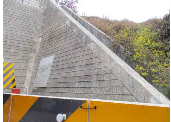
시점부 옹벽 전경
